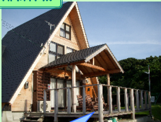
ウッドデッキテラス
